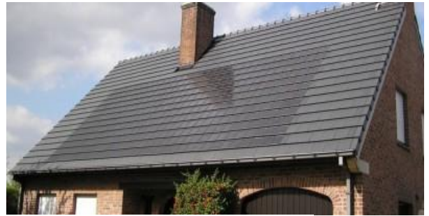
Zonnecellen als onderdeel van het dakvlak
