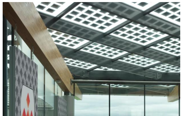
Zonnecellen in een glasdak bijvoorbeeld bij serres
